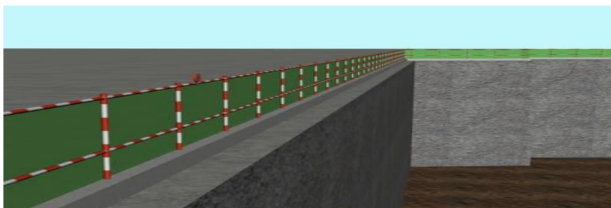
基坑临边防护
